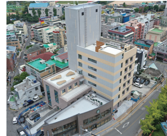
별관 신축 전경
